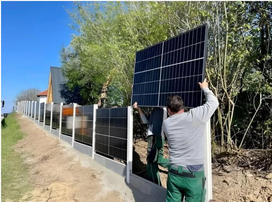
**Fig.25** Installation de panneaux photovoltaïques, ici en Allemagne, en position verticale. La production hivernale est favorisée, au détriment du rendement estival.
