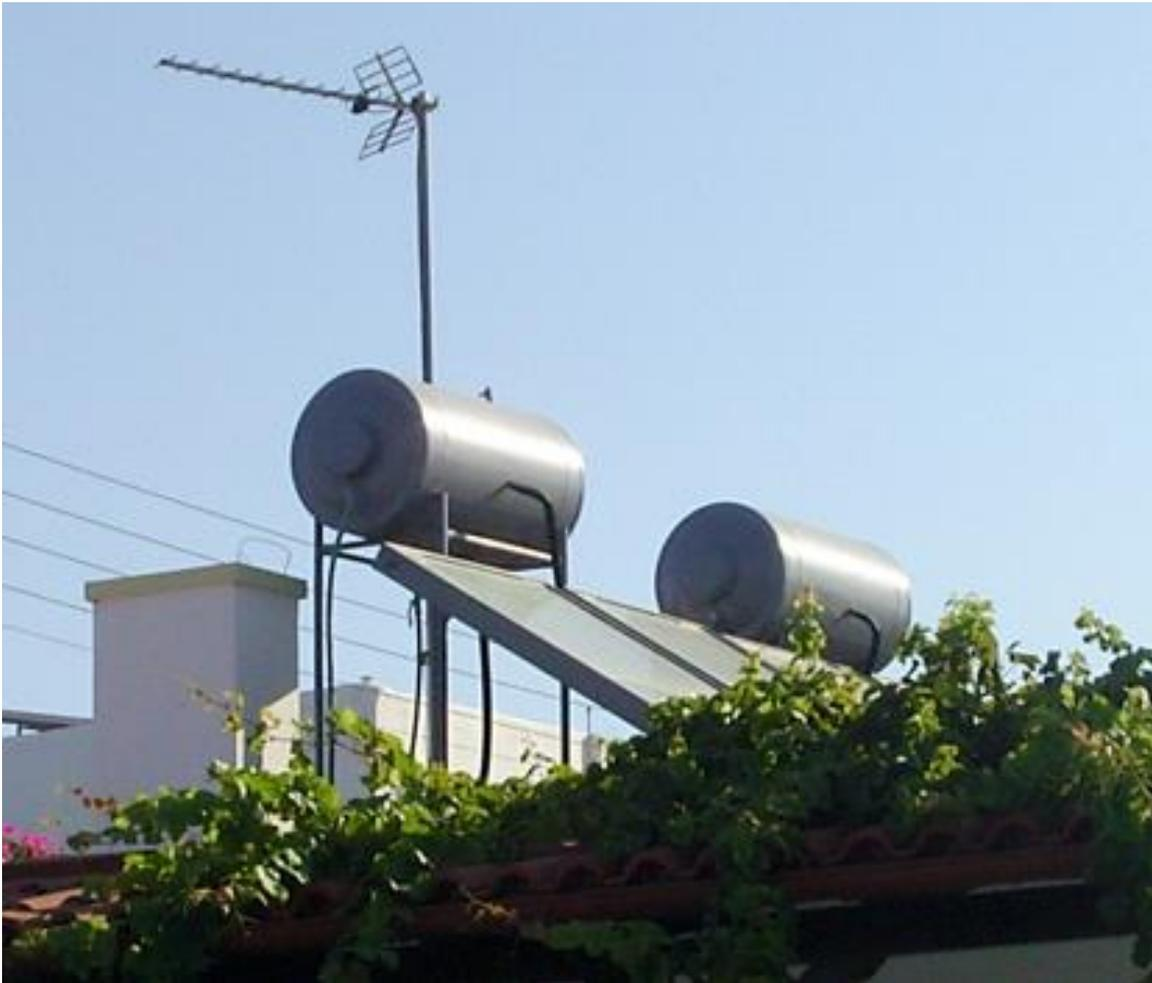
**Fig.26** Installation d'un chauffe-eau solaire en Crète (35 °N). La position inclinée des capteurs favorise l'éclairement hivernal.
