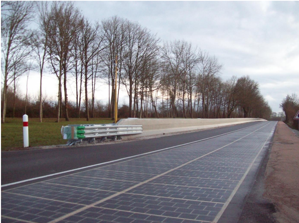
Fig.19 Exemple d'installation photovoltaïque horizontale, ici une route. La production annuelle est des plus médiocres.
