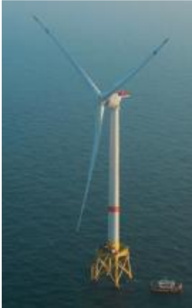
L'éolienne Haliade de 6 MW. La hauteur est de 173,5 m pales comprises La surface balayée par ces dernières est de 16972 m 2 . La vitesse tangentielle à l'extré- mité des pales est comprise entre 30,8 et 88,5 m. s -1 (données : General Electric). Il est prévu d'installer 80 aérogénérateurs de ce modèle au large de Guérande sur une surface de 12 km 2 .
